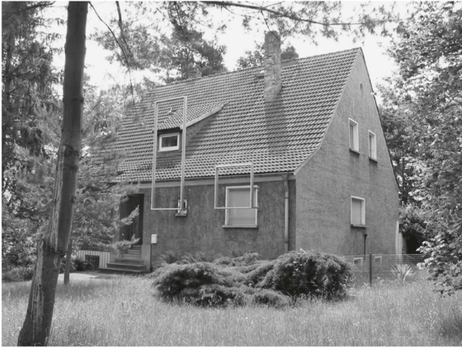
Abb. 2: Dessau, Haus Emmer, Eingangsseite mit in ursprünglicher Position angebrachten Fensterumrahmungen des Hauses Gropius, 2009 (Foto: Andreas Schwarting, TU Dresden, Institut f. Baugeschichte, Architekturtheorie u. Denkmalpflege).
