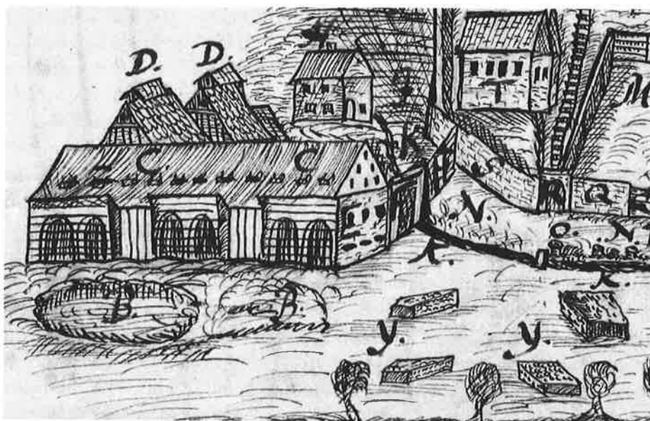
Abb. 1: Die Pirnaer Ziegelscheune um 1730. Erläuterungen: B = die zwey Erd-Sümpfe zu Ziegeln, C = die Ziegelscheune, D = die Bren-Öfen, Y = der Rath's-Kalkstein-Platz (Stadtarchiv Pirna, B I-VII Nr. 34).
