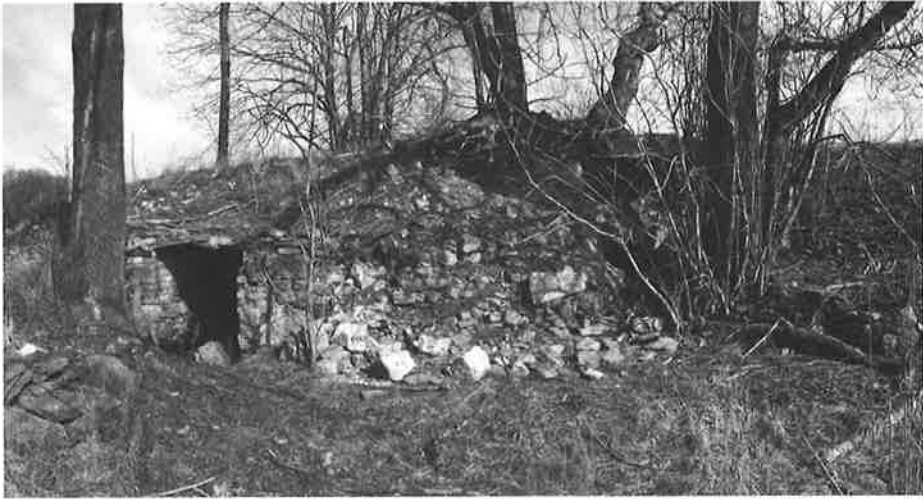
Abb. 5: Gut erhaltener »Schneller«-Feldofen in Herbergen bei Liebstadt. Zu erkennen sind zwei Öffnungen der so genannten »Schütträumek«, in denen der Kalk trocken gelagert werden konnte, nachdem er aus dem Brenntrichter gezogen worden war (Foto: C. Bieberstein, März 2012).
